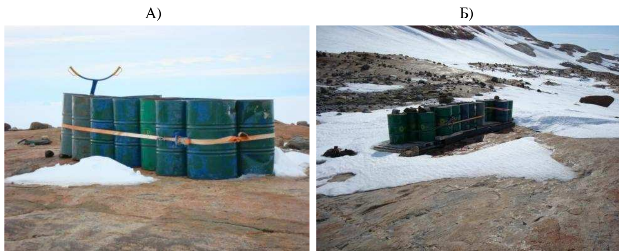
Рисунок 3.21 – Общий вид мест хранения металлических бочек с топливом: а) на скальных породах; б) на деревянных поддонах
